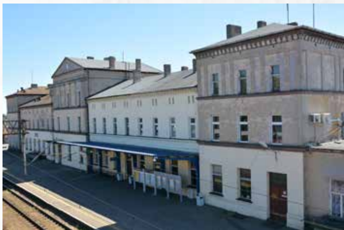
Dworzec kolejowy w Krzyżu Wielkopolski
